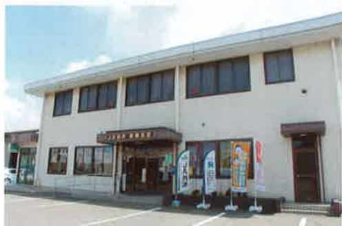
平成元年から地域の皆さまにご利用頂いた岩井西支店
