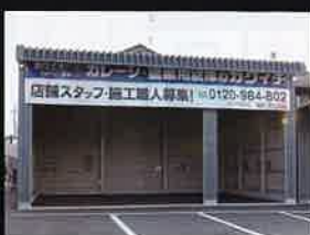
ガレージ兼用倉庫
